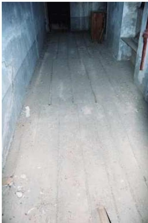
IL SOFFITTO DELL'ATRIO (M.7,80X1,80) FUNGE ANCHE DA PAVIMENTO AL SOPRASTANTE MATRONEO: SONO 27 TAVOLE SOSTENUTE DA 13 TRAVETTI (SEZIONE CIRCA CM.10X14) IL TUTTO IN DISCRETO STATO DI CONSERVAZIONE.
