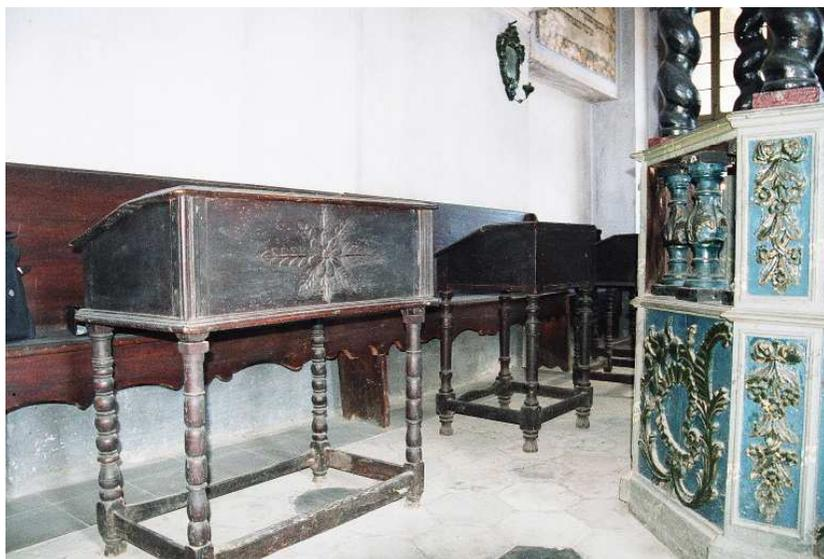
NUMEROSE PANCHE NEL TEMPIO, NELLA SCUOLA E NEL MATRONEO SONO TARLATE E NECESSITANO DI VERNICIATURA. I BANCHI DI PREGHIERA E DELLA SCUOLA, ALCUNI DEI QUALI SONO INTARSIATI, SONO ANNERITI, TARLATI CON SCONNESSIONI E HANNO CORNICI MANCANTI, CERNIERE E SERRATURE ROTTE.
