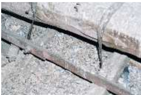
DETTAGLIO DEI SOSTEGNI DELLA VOLTA
